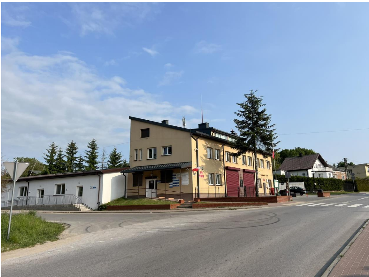
Fot.własna: budynek Urzędu Gminy w Wierzbnie
